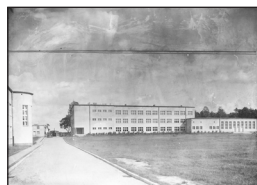
Wojewódzki Zakład dla Głuchoniemych i Ociemniałych w Lublińcu, proj. Tadeusz Łobos, Jan Zarzycki, fot. J. Bułhak, 1936
