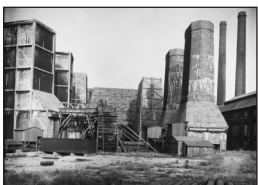
Górnosląskie Zakłady Elektryczne w Chorzowie. Chłodnie kominowe, fot. J. Bułhak, 1936
