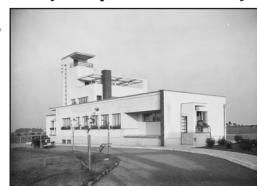
Budynek „dworca” na lotnisku szybowcowym w podbielskich Aleksandrowicach, proj. Karol Schayer, fot. J. Bułhak, 1936
