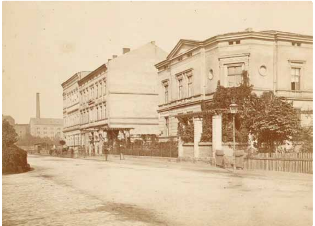
Dworcowa fragment ściany północno-zachodniej
