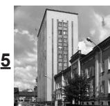
5 Chorzów – Komunalna Kasa Oszczędności, ul. Zjednoczenia 1, ul. Wolności 41a, 1936-1937 r.
